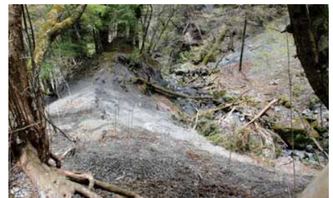
支谷沿いの斜面の崩れ（2016年）
