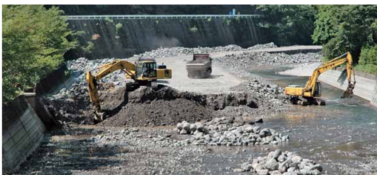
大量の土砂が堆積した物部川上流 (2006年、この後5年程度で再堆積) 夕立でも濁るフスベヨリ谷 (2013年)
