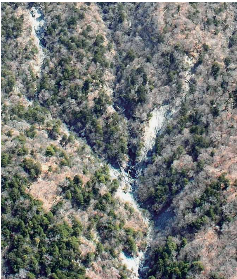
長笹谷上流部の沢沿い斜面の崩れは深刻（2012年、空撮）
