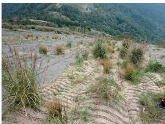
図 10 2012 年設置シートに定着・成長したススキ群落。中央から右寄りの横縞のあるシートが 2012 年設置のシート。
