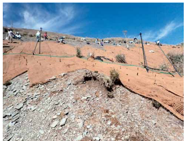
図8 植生保護シート敷設作業。2015年10月3日撮影。
