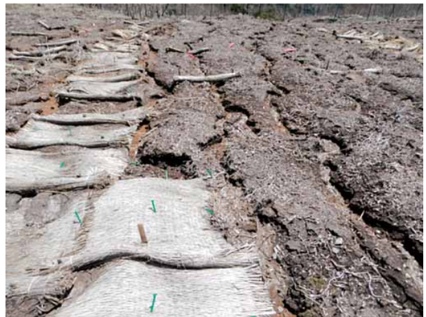
図6 敷設した菰の横に新たに形成されたガリー。2013年4月28日撮影。
