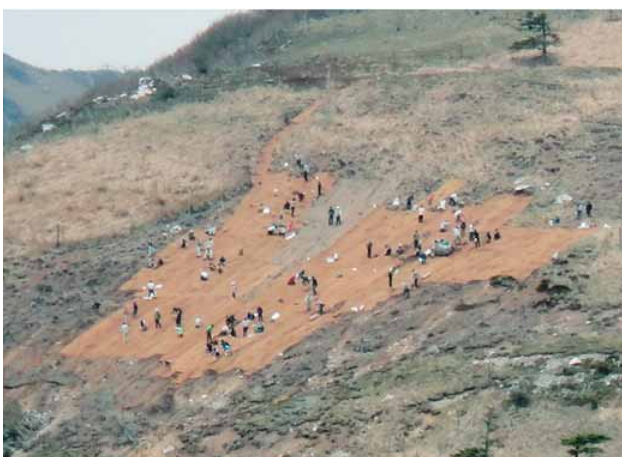
図7 植生保護シート敷設作業。2014年5月18日撮影。
