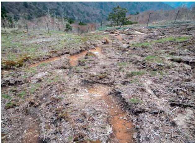
図5 表層土壌が流失してガリー状の侵食が進む斜面。2012年4月29日撮影。
